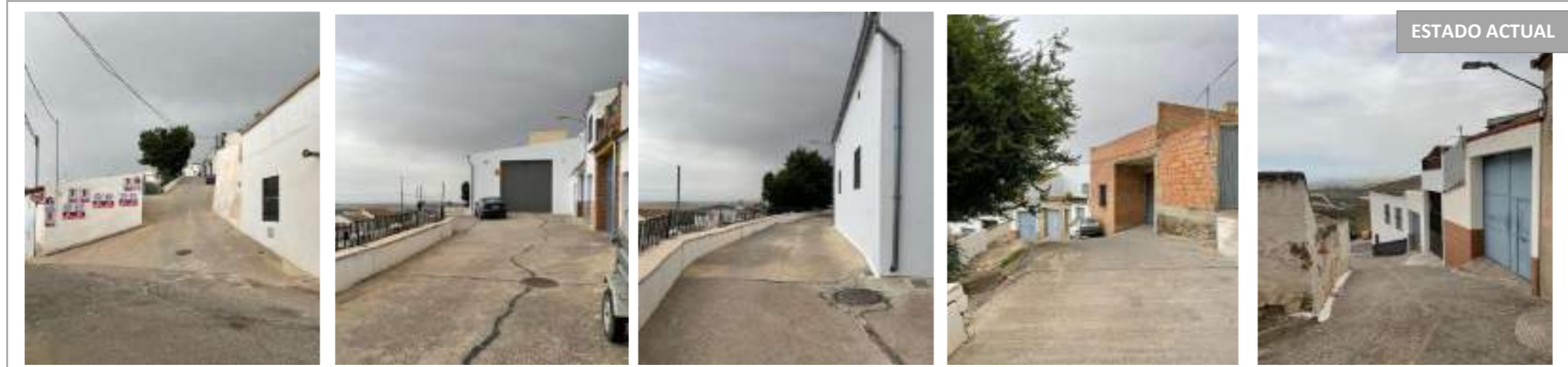
Vista a conexión TR. 1 y TR. 2 Vista a TR. 2 Vista desde Calle Empedrada Baja Vista a TR. 3 Vista hacia Calle Batalla de Munda
