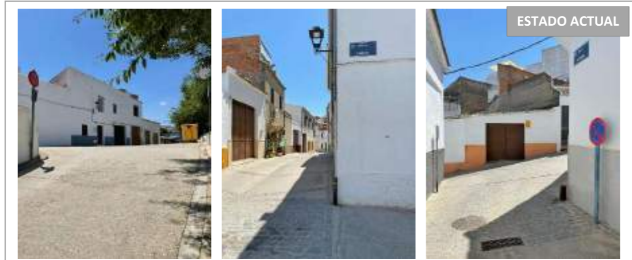
Vista desde Calle Chorro (TR. 1)
