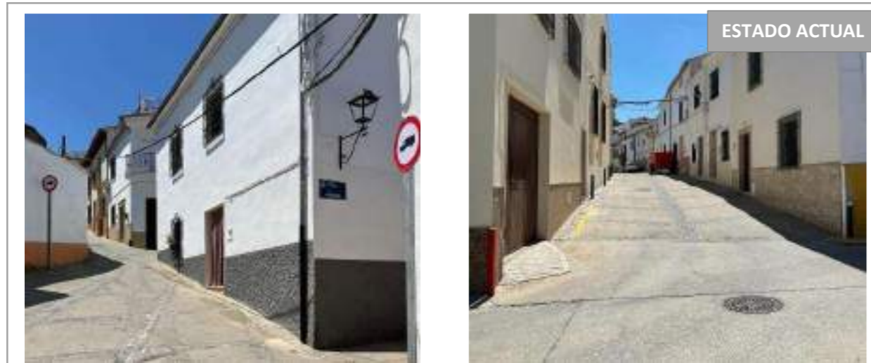
Vista desde Calle Torrecilla
