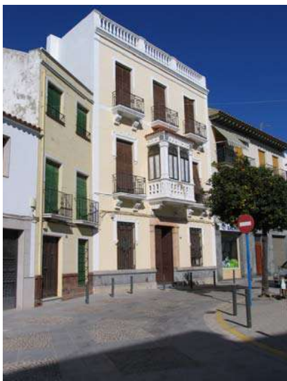
Paseo de Andalucía, nº 38
