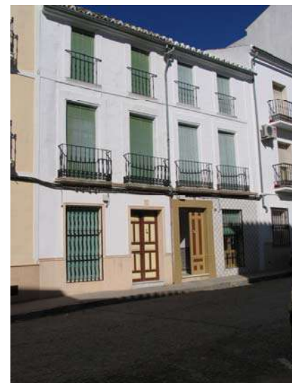
Paseo de Andalucía, nº 56+58
