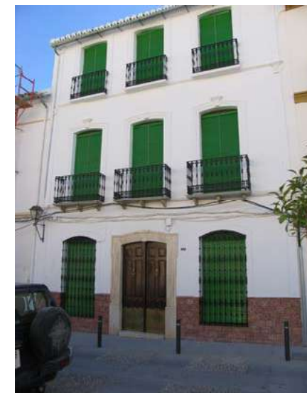
Paseo de Andalucía, nº 17
