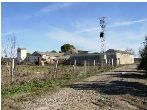
ASPECTO EXTERIOR DE CORTIJO DE FUENTE ESPINO
