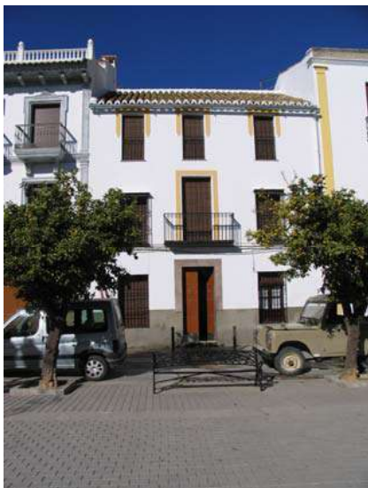
Paseo de Andalucía, nº 12
