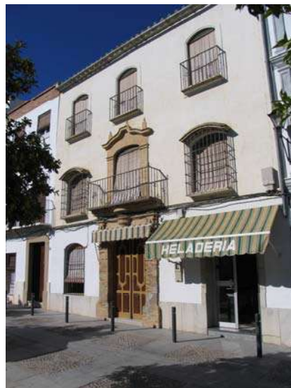
Paseo de Andalucía, nº 16
