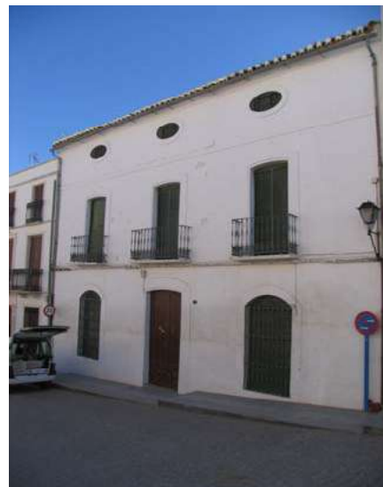
Paseo de Andalucía, nº 3
