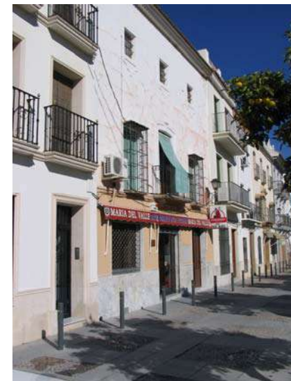
Paseo de Andalucía, nº 22
