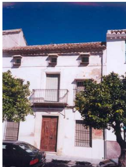
Paseo de Andalucía, nº 14
