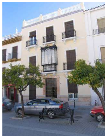
Paseo de Andalucía, nº 21
