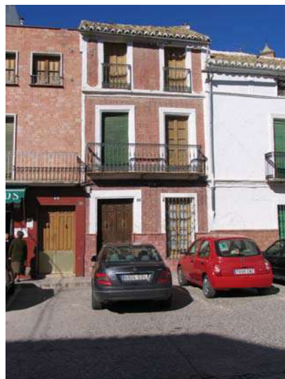
Paseo de Andalucía, nº 44
