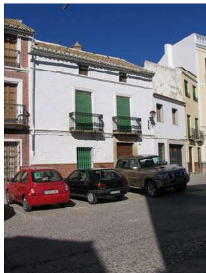
Paseo de Andalucía, nº 44
