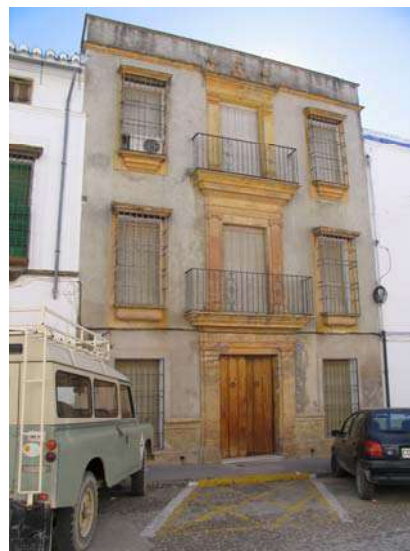
Paseo de Andalucía, nº 45
