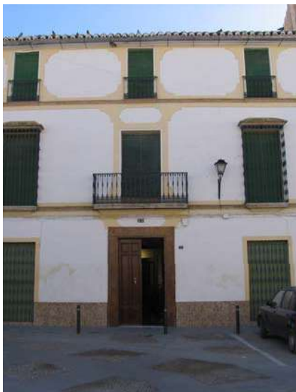
Paseo de Andalucía, nº 33
