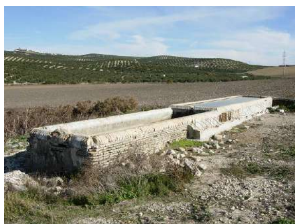
FUENTE DE BAÑUELOS BAJOS
