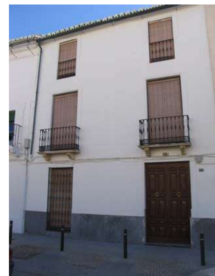
Paseo de Andalucía, nº 27
