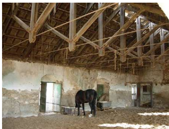
ESTRUCTURA DE CERCHAS DE MADERA EN CUBIERTA DE CUADRA
