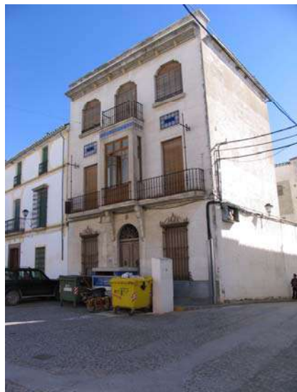
Paseo de Andalucía, nº 35
