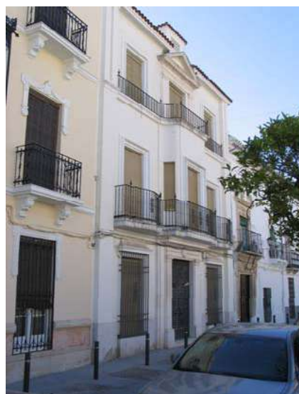
Paseo de Andalucía, nº 23
