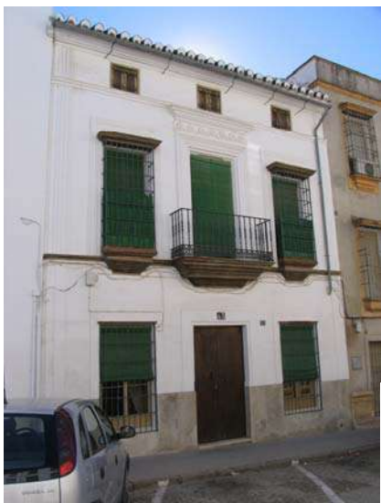
Paseo de Andalucía, nº 43
