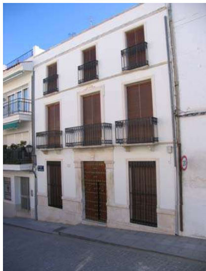
Paseo de Andalucía, nº 1
