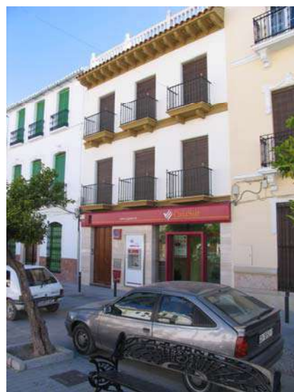
Paseo de Andalucía, nº 19
