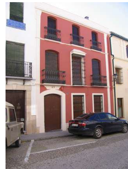
Paseo de Andalucía, nº 49
