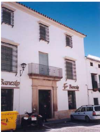
Paseo de Andalucía, nº 41
