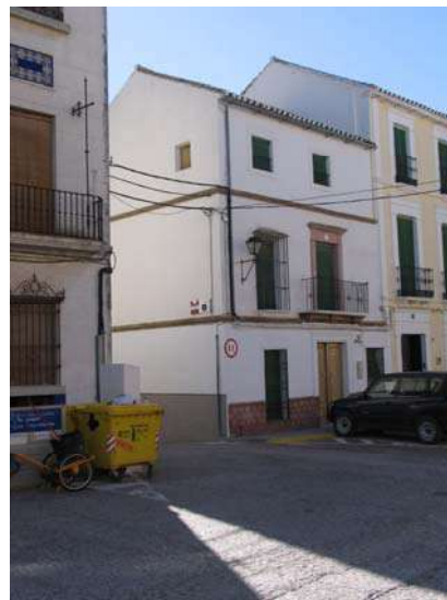
Paseo de Andalucía, nº 37
