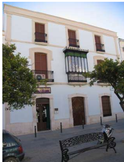
Paseo de Andalucía, nº 11
