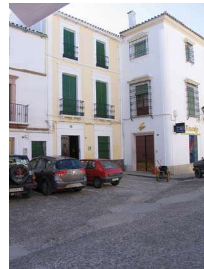
Paseo de Andalucía, nº 39
