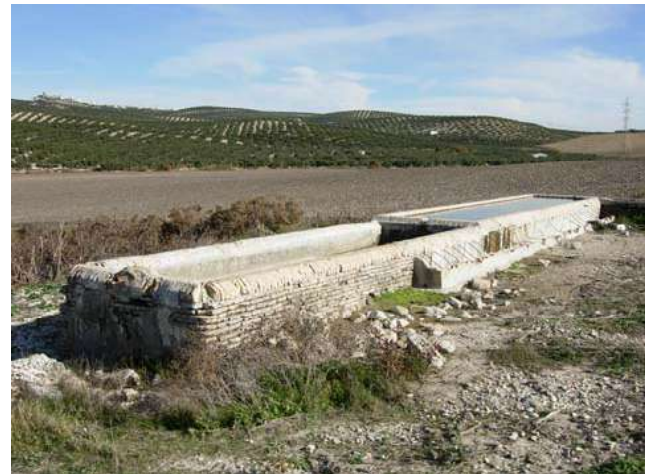
Fuente de Bañuelos Bajos
